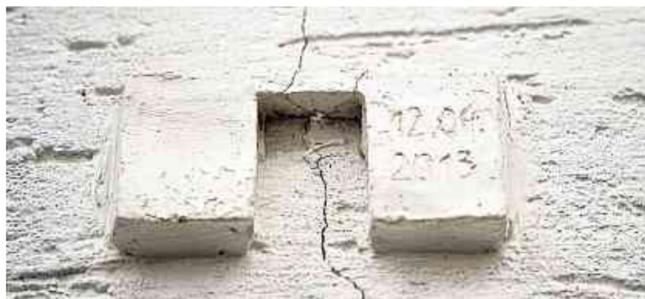
Diese Gipsmarke am Haus von Volker Vogt zeigt, dass die Erschütterungen der Züge den Putz der Außenfassade immer weiter reißen lassen.
